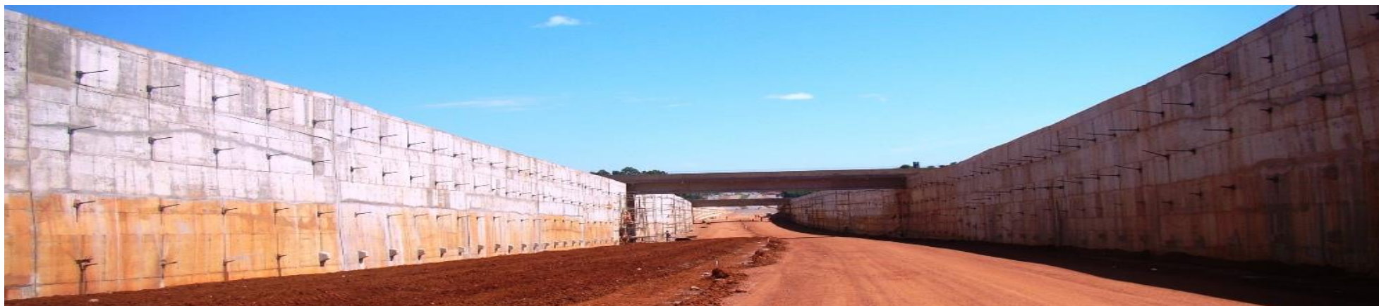
Cortina Atirantada Viaduto BR 153
