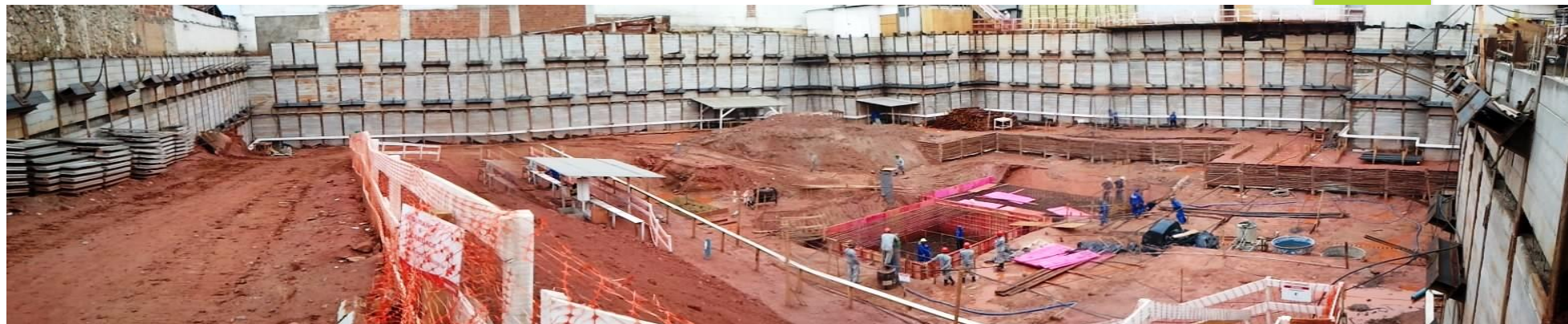
Contenção com Perfis Metálicos - 3 Subsolos
